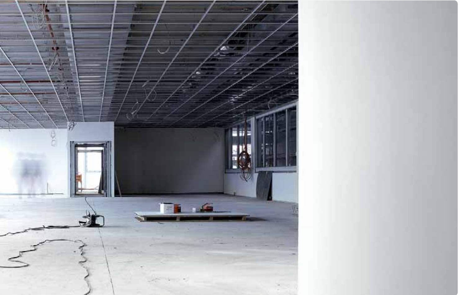
Ein Arbeiter (l.) im Zeitraffer: In der neuen Halle der Lufthansa-Technik wird mit dem Einbau von Heizung, Lüftung, Sanitär und Elektrik begonnen
