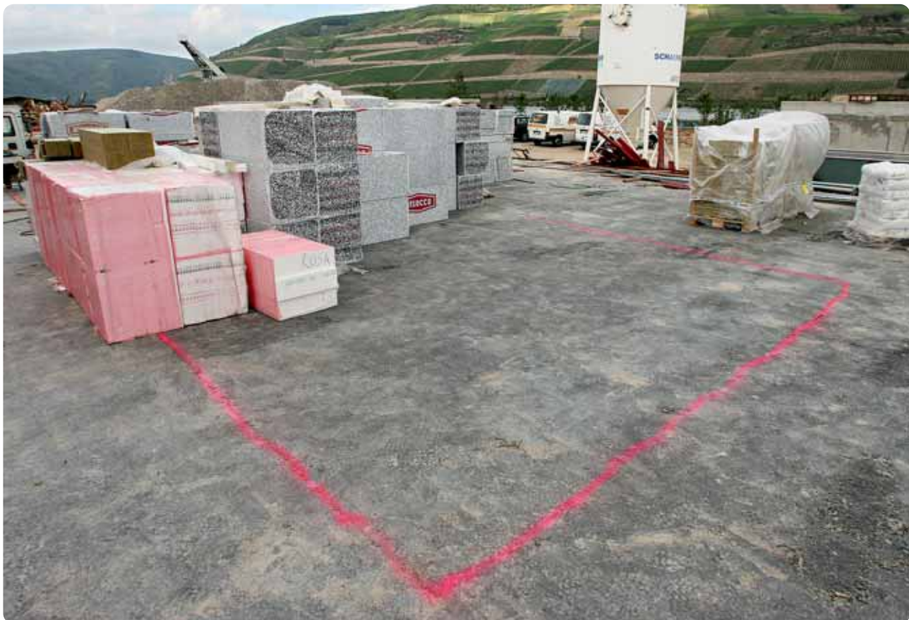
Parkbucht auf dem Bau: In Bingen haben überschaubare Bestände ihren festen, markierten Platz
