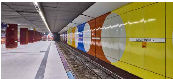
Aus Alt mach Neu: In zehn Tagen wurde der Bahnsteig Jungfernstieg modernisiert. Die Dokumentation per Film und Foto schafft Motivation, die neuen Methoden in weiteren Bauprojekten anzuwenden.
