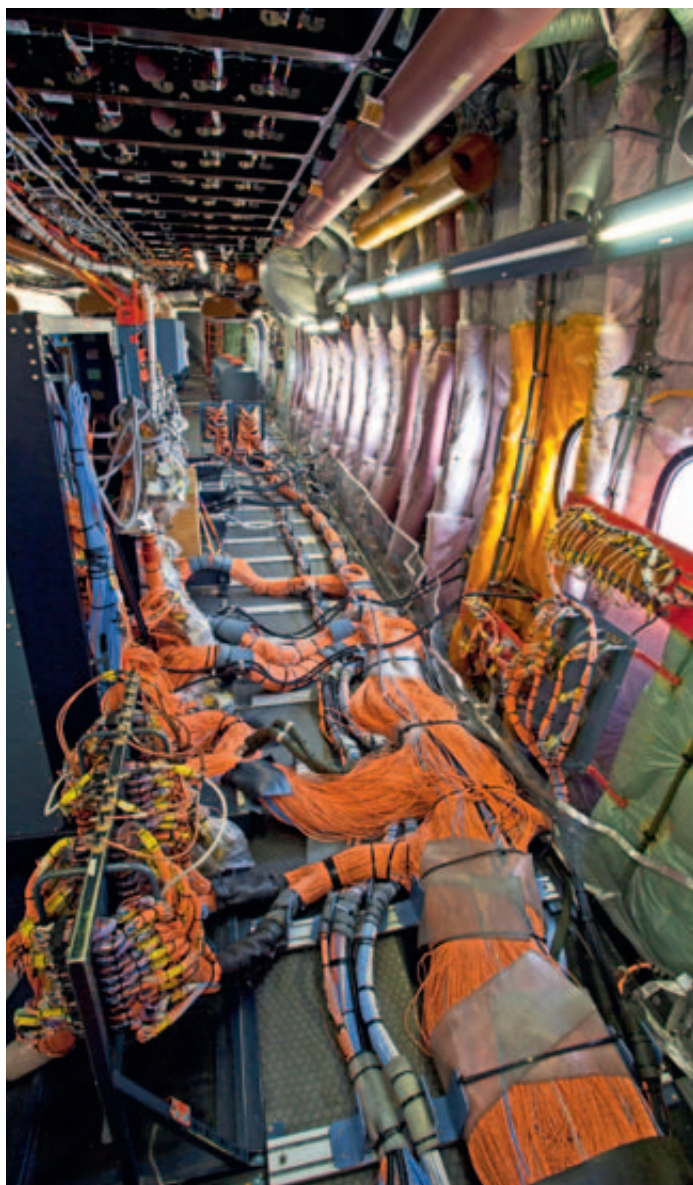
Nackte Kabine im Test-Airbus A380: Kabel und Rohre liegen blank.
